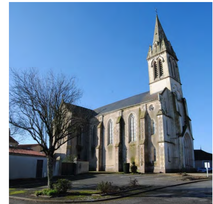
Figure 135 : Vue V14 de l'Église de Château-Guibert
