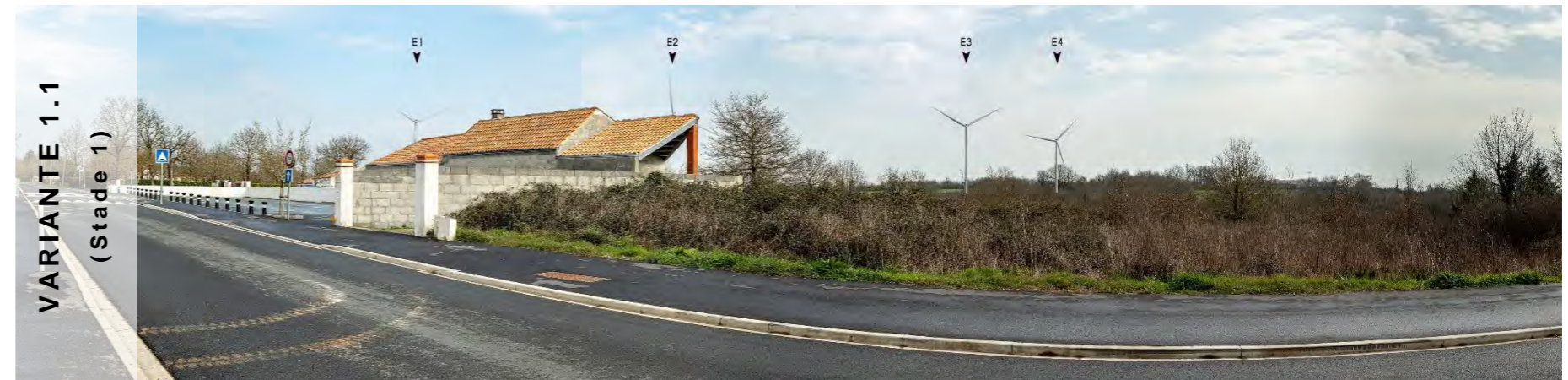
Figure 177 : Visualisation de la variante 1.1 (Stade 1) sur le PM42– Vue depuis la D60 au niveau du cimetière de Château-Guibert
