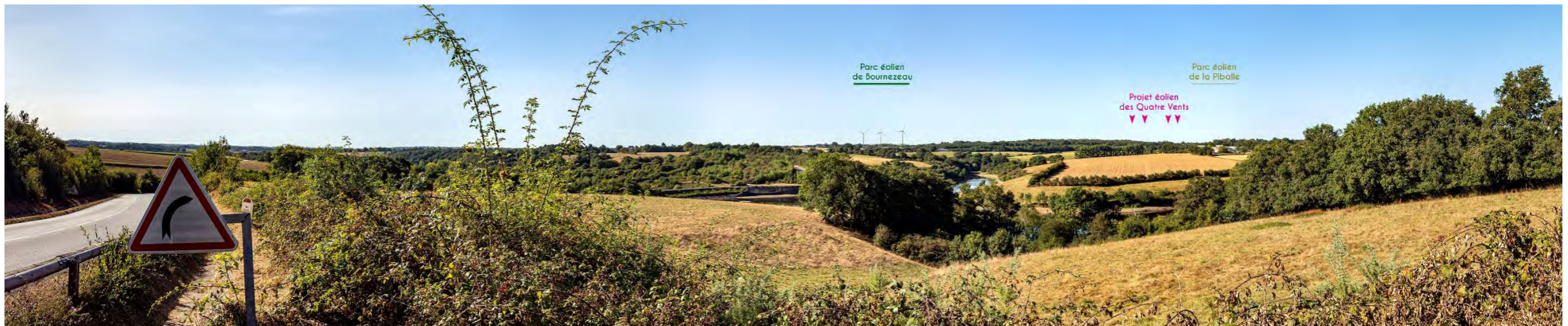
Figure 213 : PM3 – Vue depuis la D48 sur la vallée de la Vouraie, au droit du lieu de vie La Sillonnière
